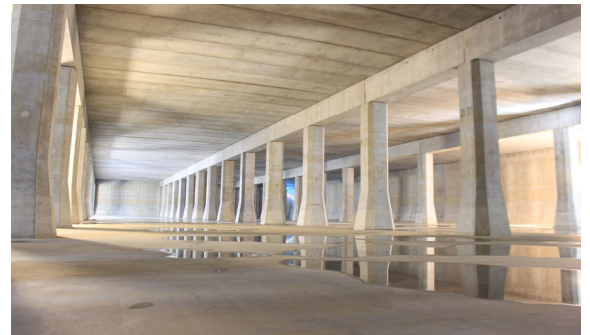
写真-6 施工完了後
