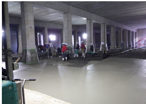
写真-5 底版コンクリート打設
