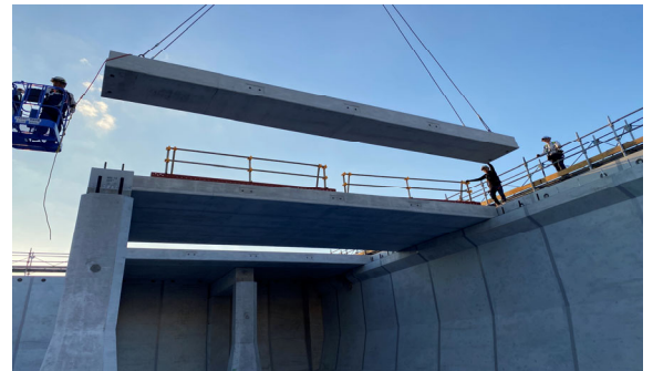
写真-4 屋根梁の架設
