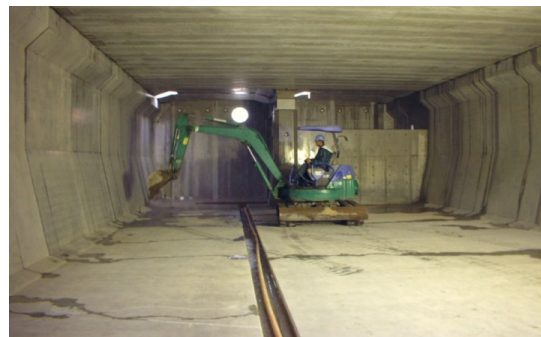
写真-7 小型重機による清掃作
