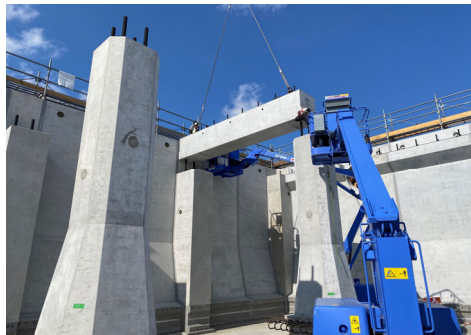
写真-3 支持梁の架設
