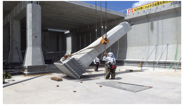
写真-2 中間柱の架設
