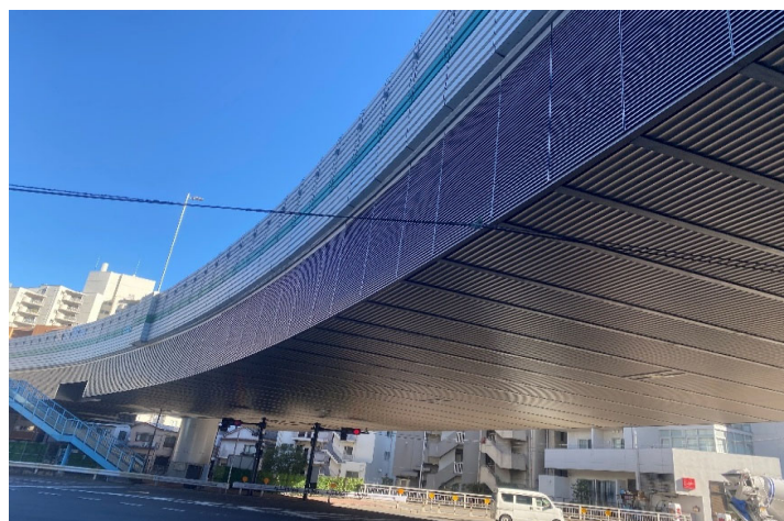
図－７ パーマネントデッキ設置事例２（開放型）
