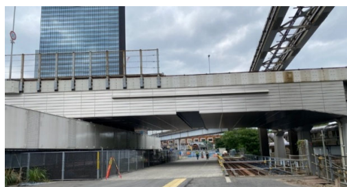
図－６ パーマネントデッキ設置事例１（密閉型）
