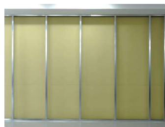
①LGSで下地を設置する
