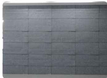
⑤施工完了
