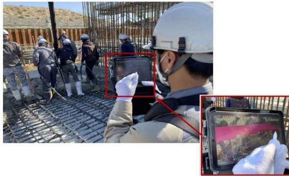
図-1 本システムを用いた作業の様子
