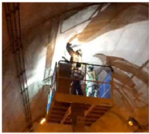
通常の打音検査
