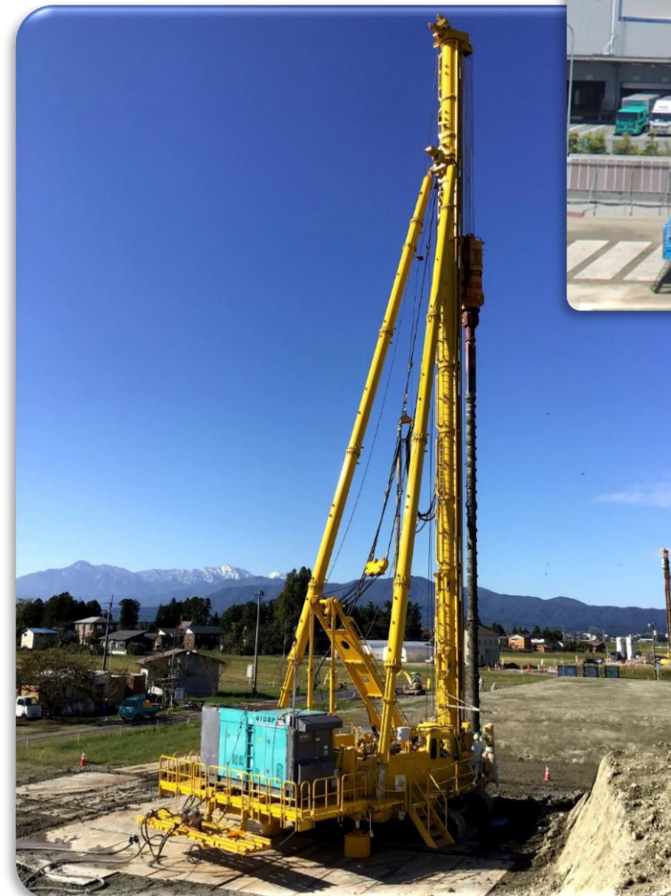
【ICT-深層混合処理工法】
