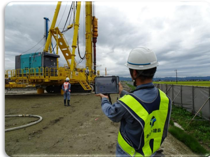
【ICT-深層混合処理工法】
