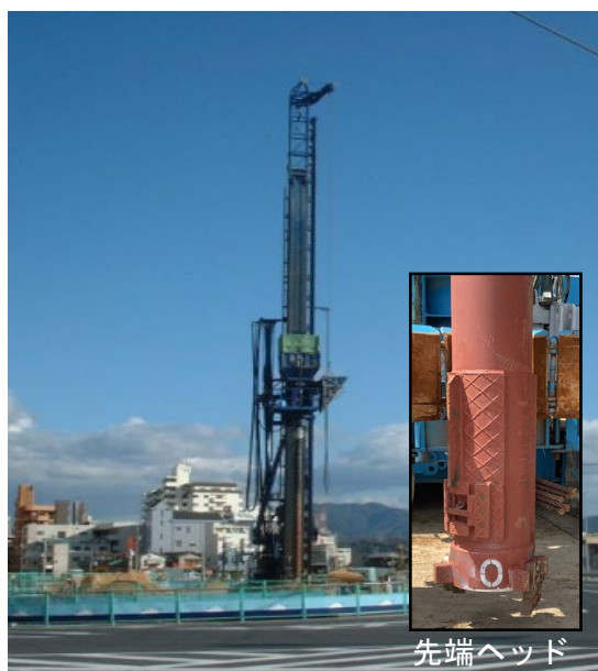
施工状況 (KS-EGG-SE工法)
