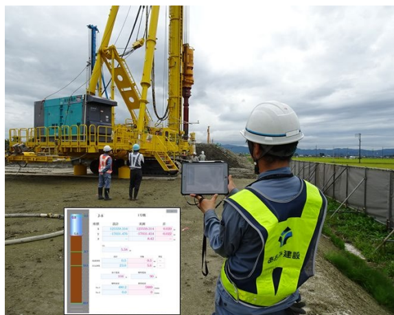
タブレットによる確認状況
