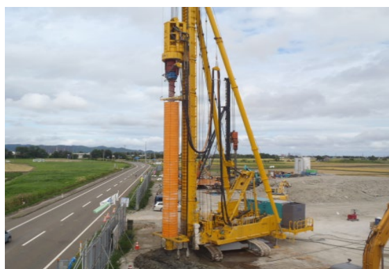
施工状況 (S・MIX工法)
