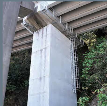
夕吹高架橋検査路 施主：静岡県熱海土木事務所 伊東支所 場所：静岡県伊東市
