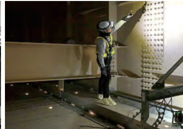
桁内部点検作業の様子
