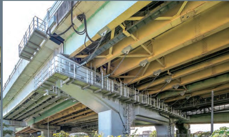
夕吹高架橋検査路 施主：静岡県熱海土木事務所 伊東支所 場所：静岡県伊東市
