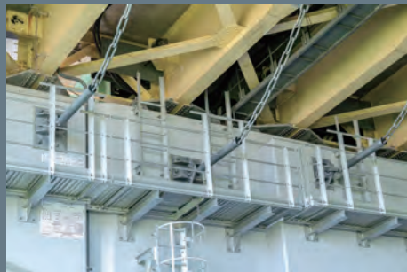
萬丈橋検査路 施主：中日本高速道路株式会社 場所：神奈川県小田原市
