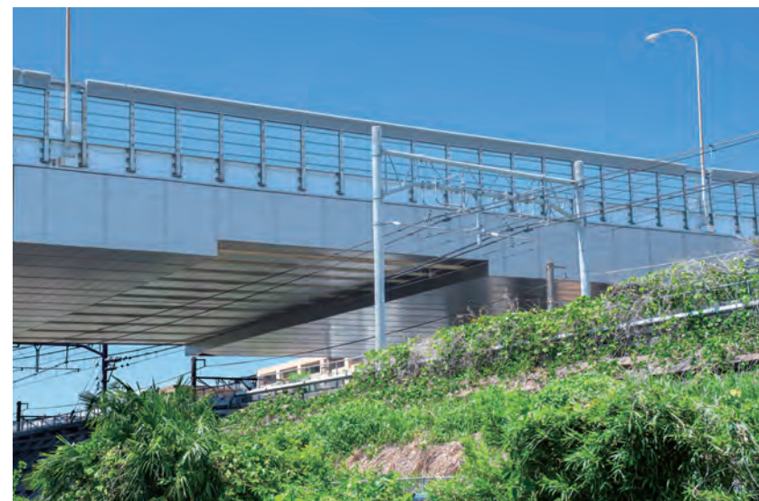
法泉高架橋／神奈川県 既設橋に設置
