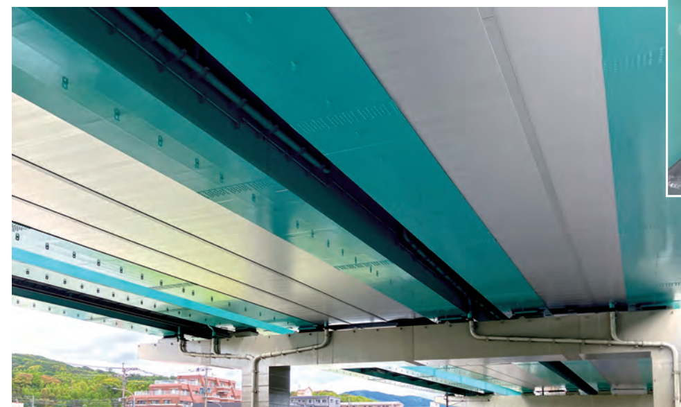
福岡高速 2 号線（金の隈～大野城）／福岡県 既設橋に設置
