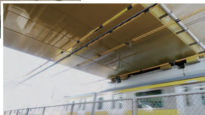
小松橋／東京都 既設橋に設置
