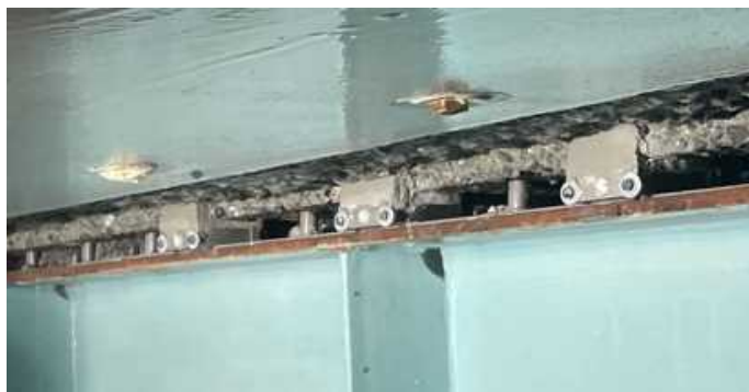
写真-3 仮補強材設置状況
