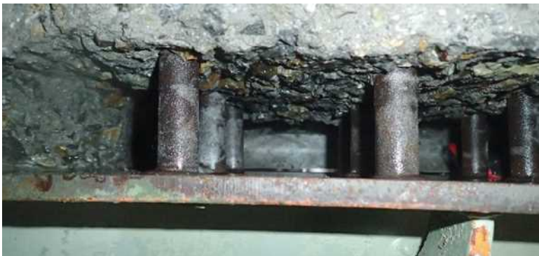
写真-2 接合部除去状況
