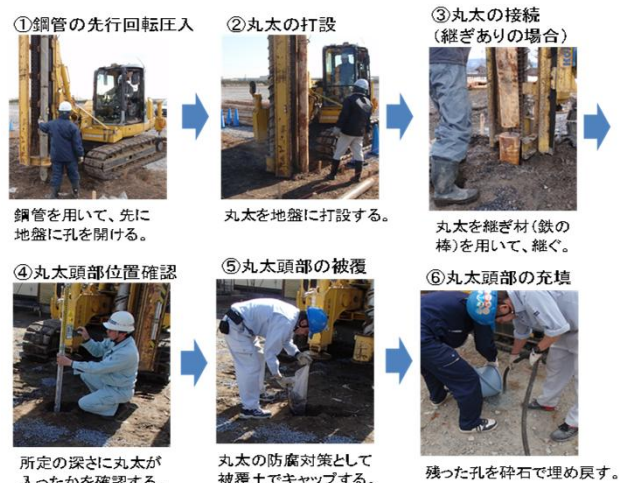
図-2 LP-LiC工法の施工手順
