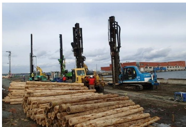
写真-1 LP-LiC工法の施工状況
