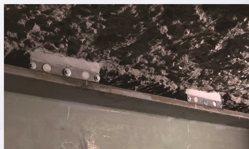
仮設補強材(鋼製補強材+特殊モルタル)
