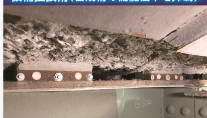
鋼製補強材+特殊モルタル
