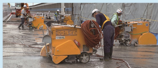
防水足場を使用する事によりウォータージェット以外にもさまざまな湿式機械の使用が可能
