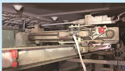
WJ施工状況(接合部の除去)
