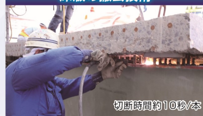
プラズマ切断による熱負荷の低減
