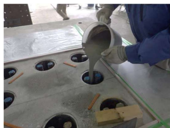
グラウト充填状況
