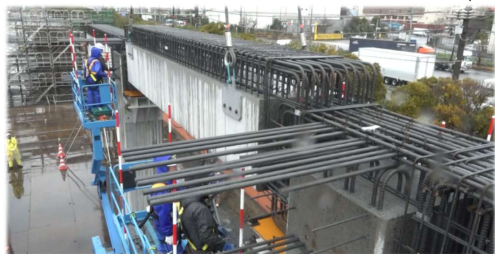
▲架設、高さ・位置調整
