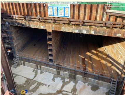
函体内部掘削完了
