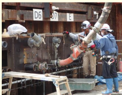
上床版中埋めコンクリート充填
