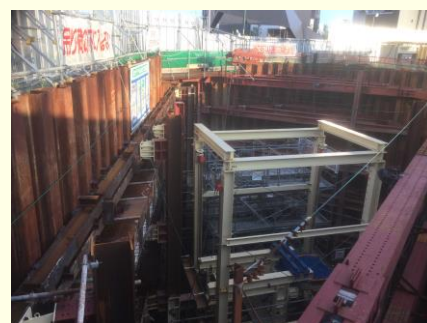
側壁エレメントけん引
