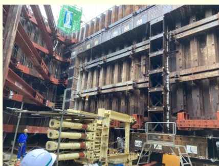
下床版エレメントけん引
