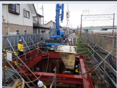
到達立坑 刃口回収状況
