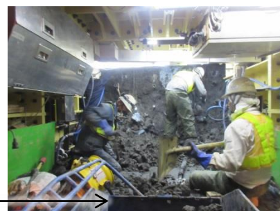
内部掘削状況（外寸 3.0m×2.0m）
