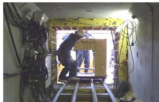
刃口分割解体（発進側送り戻し）
