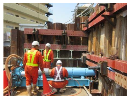
ガイドパイプ設置工
