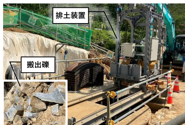
鉄塔基礎施工状況
