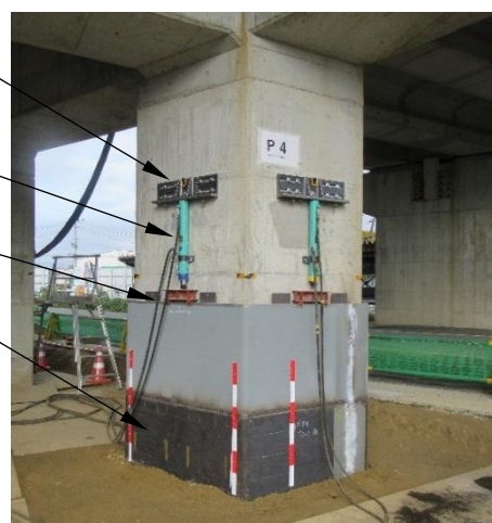
〔鋼板圧入状況〕
