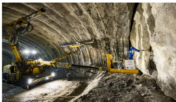
図-3 遠隔装填・結線システムの概要
