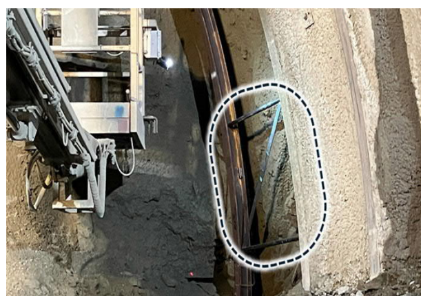
図-7 クイックテレクターの概要
