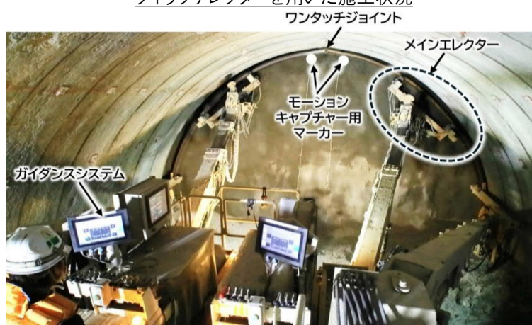
図-7 クイックテレクターの概要
