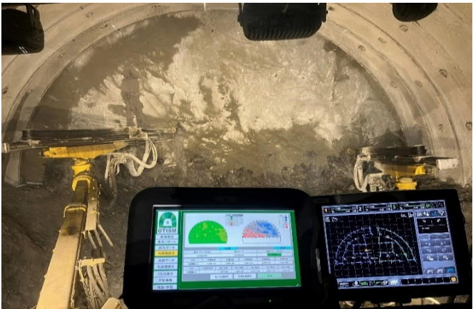
図-2 最速発破パターン作成システム「ブラストスキルAI」と「全自動ジャンボ」の概要
