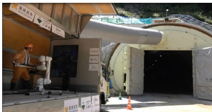
図-3 遠隔装填・結線システムの概要
