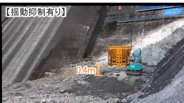
図8 放出時における揺動抑制の比較(左:揺動抑制無し、右:揺動抑制有り)
