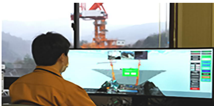
図9 タワークレーン遠隔制御状況
