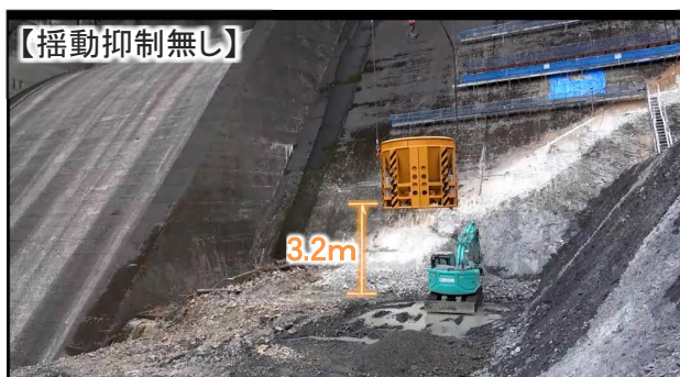
図8 放出時における揺動抑制の比較(左:揺動抑制無し、右:揺動抑制有り)
