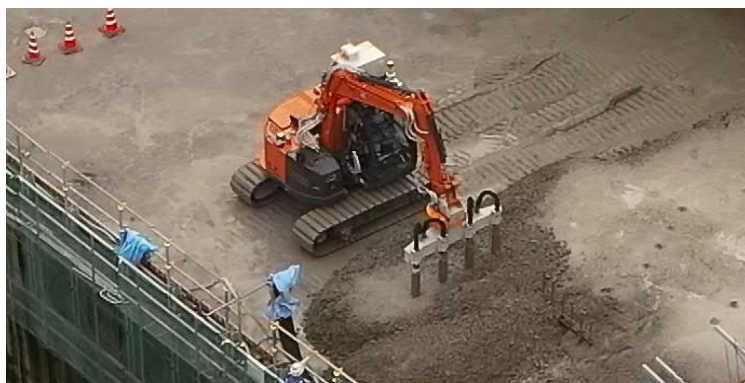
図3 コンクリート締固め状況
