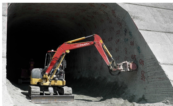
図11 壁面仕上げ状況
