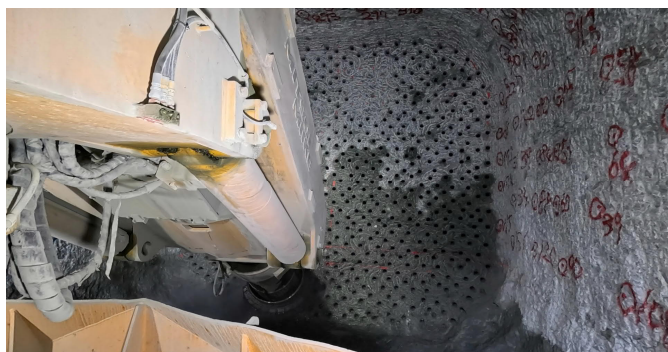
図10 堤体切削状況
