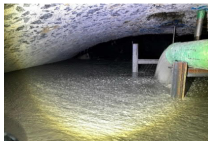
図8 高流動配合のクリーンクリート (新丸山ダム旧仮排水トンネル閉塞工)
