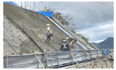
図9 クリーンクリートショットSL 施工状況(のり面吹付)
