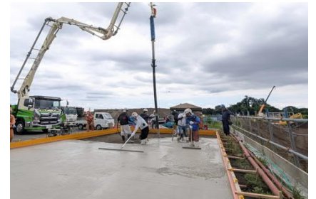
図11 クリーンクリートNの打設状況 (仮設の機械設備基礎)
