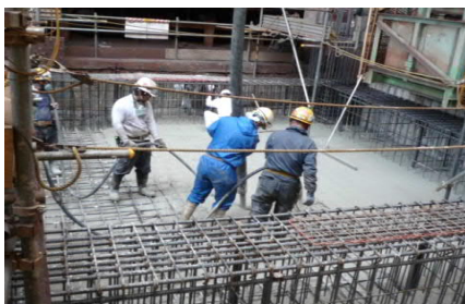
図6 クリーンクリートの打設状況 (本設の機械設備基礎)
