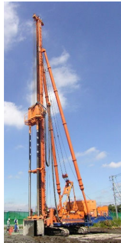
深層混合処理工法 (スラリー攪拌工 二軸施工 (変位低減型) \phi 1600 )
