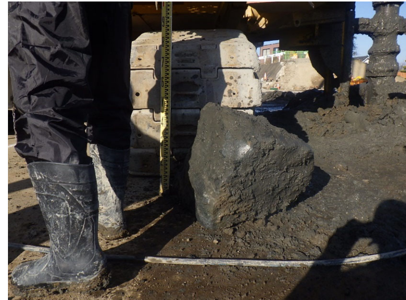
試掘した転石の例 (φ500mm程度)
