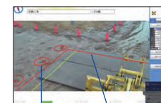
打設位置 鉄板敷設位置
