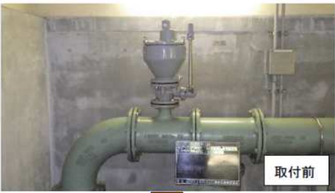
○第1工区 注入口 (写真1)
