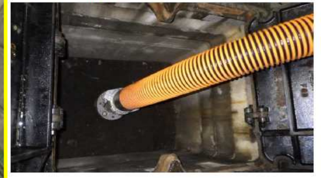
○第2工区 回収口 (写真3)
