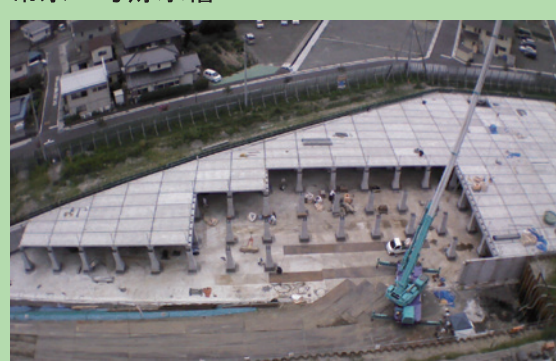
常永 2 号貯水槽
