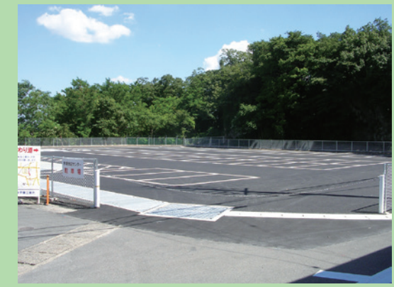
赤坂雨水調整池（駐車場）
