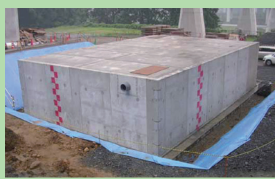
圏央道川口トンネル北貯留槽
