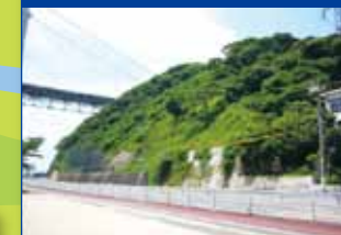
急傾斜地崩壊対策
