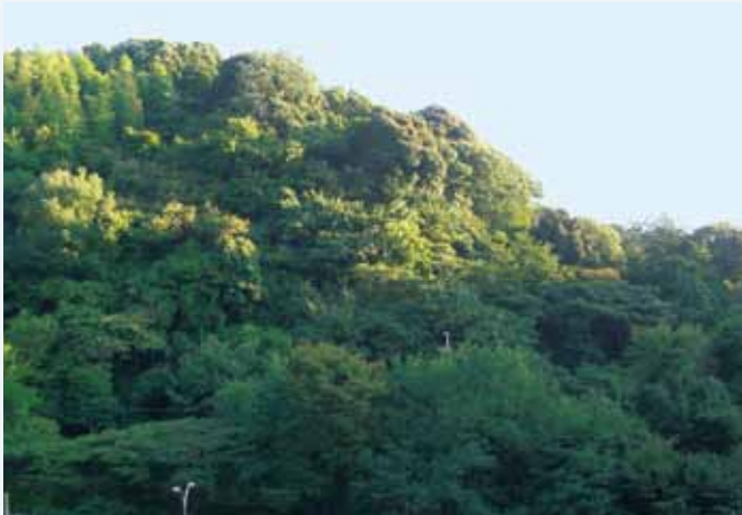
周辺の森林に溶け込んだ樹林化法面が形成
