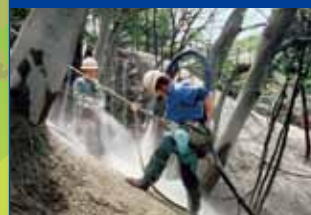
既存木の保全と法面保護
