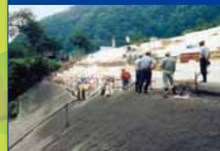
軽量盛土の覆工
