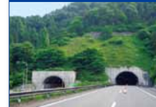
トンネル坑口の法面保護
