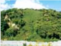
コマツナギが優占(施工後3年7ヶ月)
