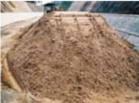
連続繊維補強土の築造状況
