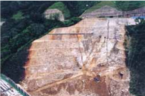
長大切土法面
