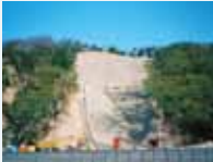
連続繊維補強土の施工
