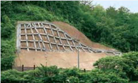
グラウンドアンカー付き法枠工を被覆修景
