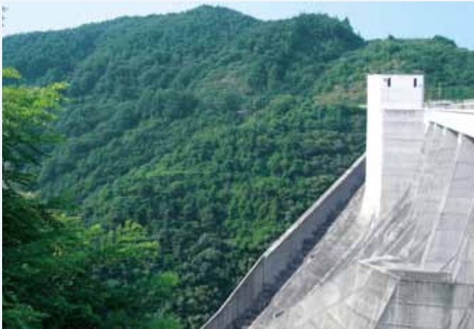
山腹の森林と調和した樹林化法面が形成
