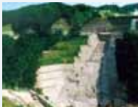
上段法面より施工(施工後6ヶ月)
