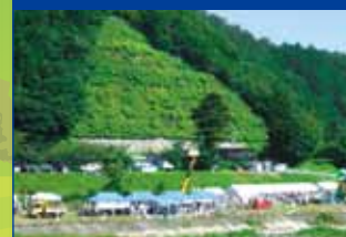
既設モルタル面の修景
