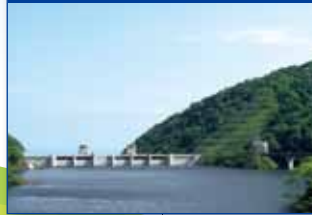
ダム堤体長大法面保護
