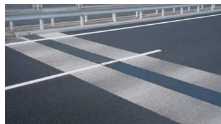
[長崎道 撰分橋] (施工: 平成24年3月)
