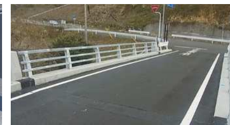
[大分県 浦久保橋] (施工: 平成25年12月)
