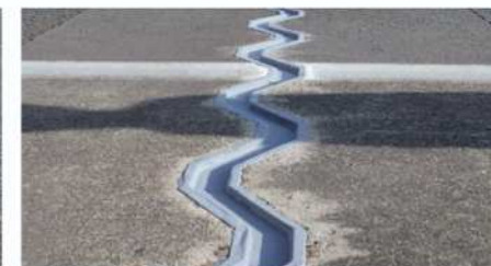
[九州道 大野高架橋] (施工: 令和3年1月)
