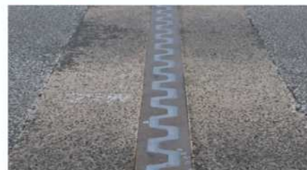
[九州道 白川橋] (施工: 令和元年9月)
