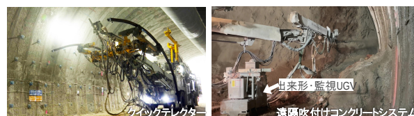
図11 宝珠山トンネルにおける施工状況
