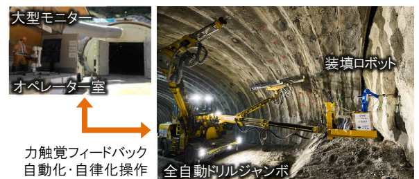
図3 遠隔装薬・結線システム
