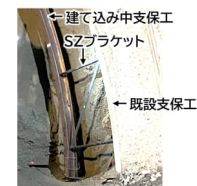
自重受け繋ぎ材「SZブラケット」設置状況
