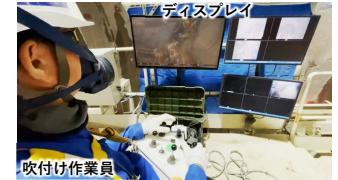
遠隔吹付け状況
