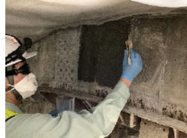
刷毛によるセバリートコートの塗布状況
