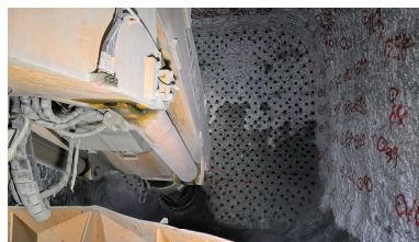
図9 堤体切削状況
