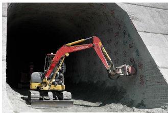
図10 壁面仕上げ状況
