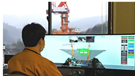
図3 タワークレーン遠隔制御状況
