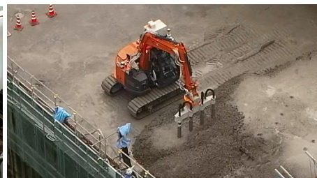
図5 コンクリート締固め状況
