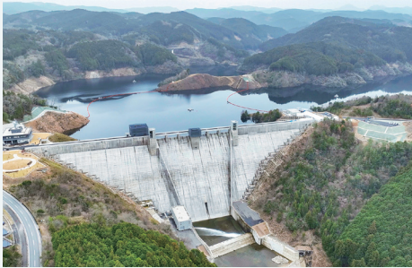
川上ダム（重力式コンクリートダム）
