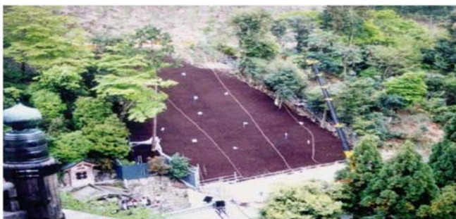
ジオファイバー工法により復旧
