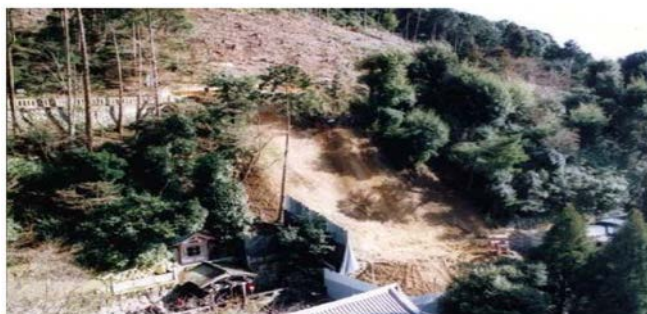
平成 11 年の斜面崩壊
