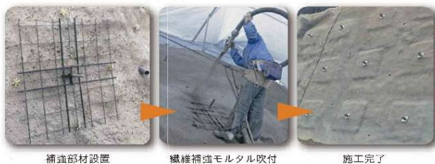
補強部材設置
