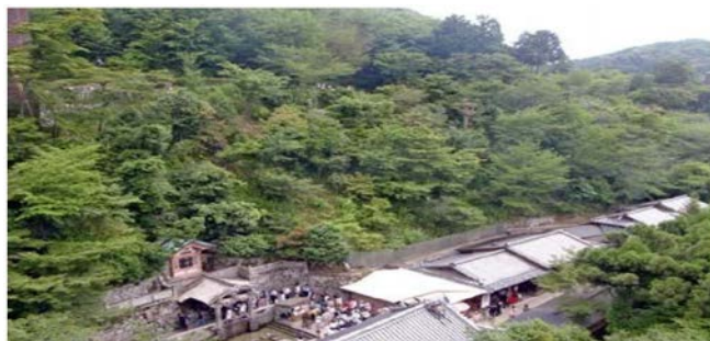
見事に緑の斜面に（施工後 12 年）
