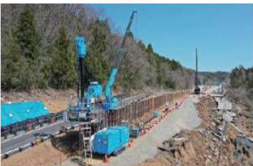
擁壁・土留め
