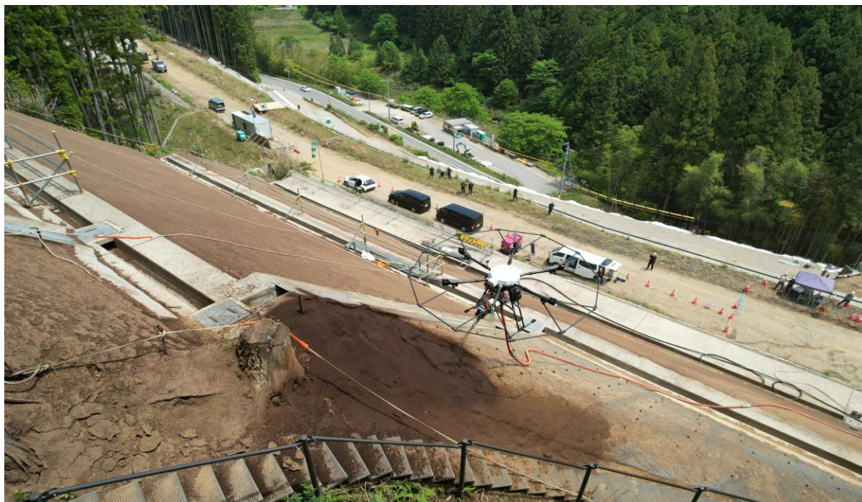
写真1 グリーンインパルスによる施工状況
