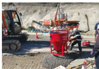
コンクリート打込み状況
