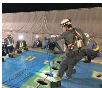
② 床版設置(専用治具を使用)
