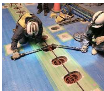
③ H型金物挿入、ボルト締付け
