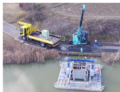
搬入・組立状況
