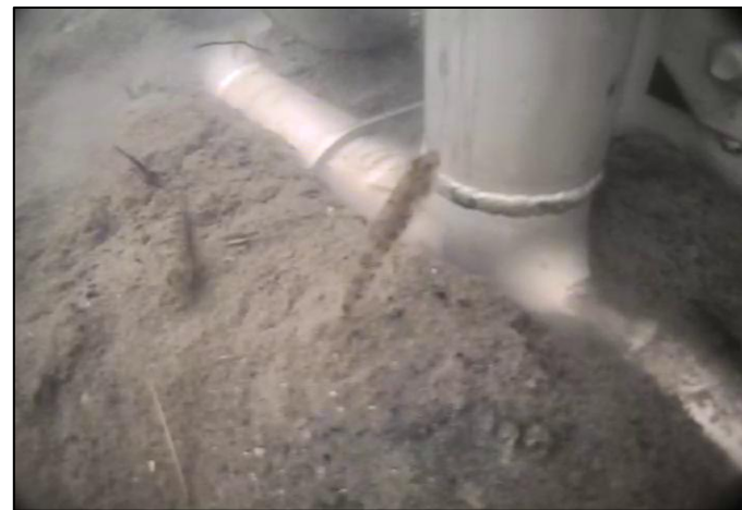
【浚渫施工中の水中写真 濁り発生なし】
