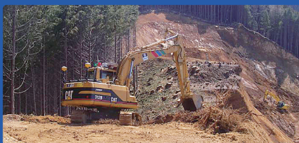
北股川北股地区河道閉塞緊急対策工事
