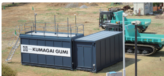
技術研究所内の屋外実験ヤード
