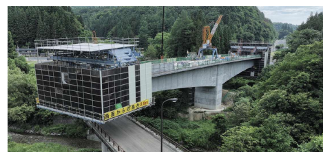
DX-Bridge構想の実証フィールドとなった中山平大橋
