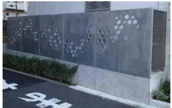
設備機器の目隠しパネルへの適用
