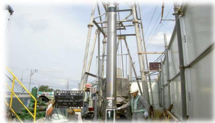
図3 KVSストレーナの設置(施工)例
