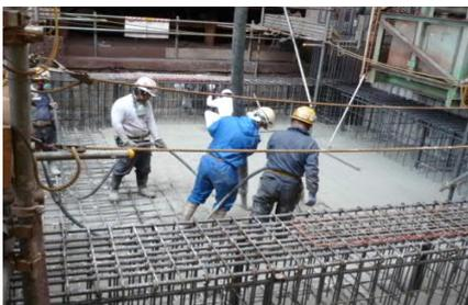
図6 クリーンクリートの打設状況(製鉄所設備基礎コンクリート)
