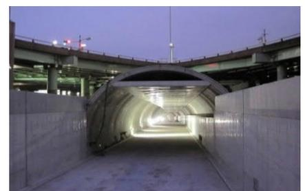
図8 U型擁壁底版への適用)
