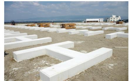
図11 メガソーラー基礎への適用
