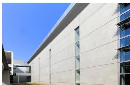
図7 建物外壁のクリーンコンクリートプレキャスト製品
