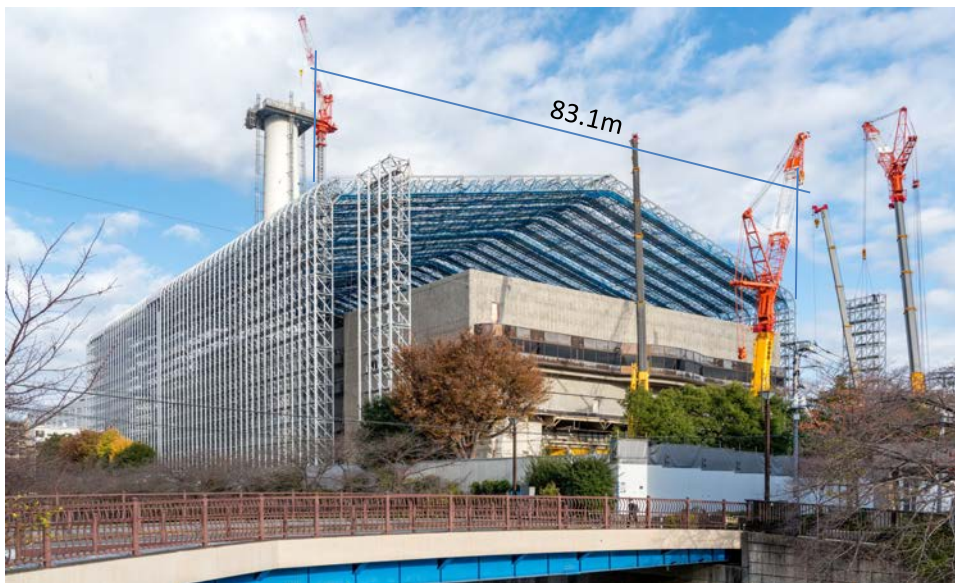
アトモス建設状況
