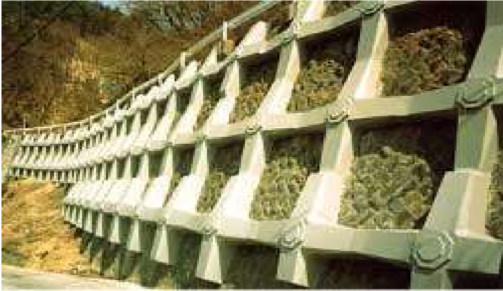
PCフレームアンカー工法
