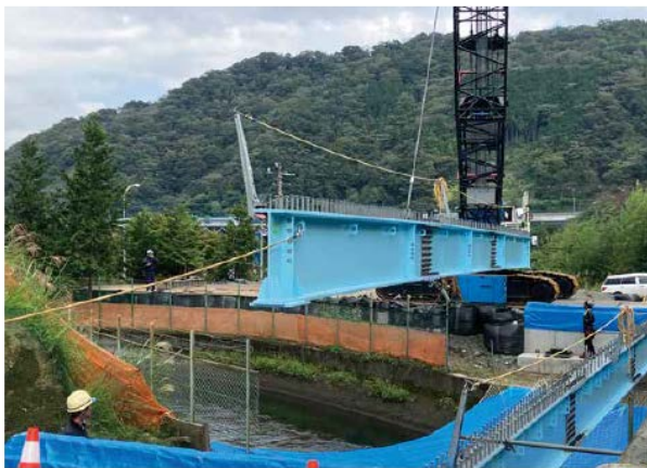
桁架設工
