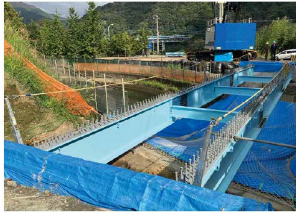
桁架設完了
