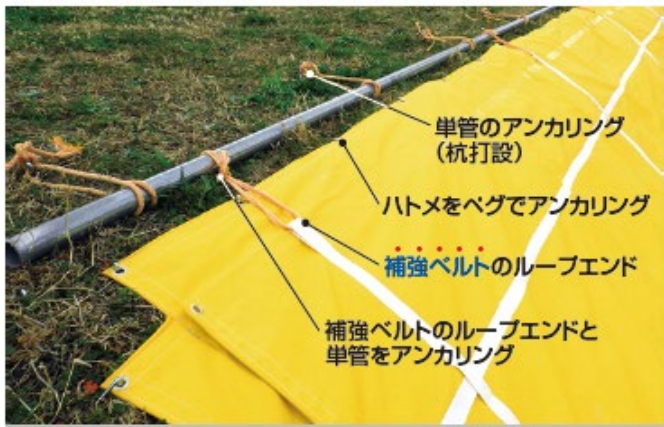
外周は杭打ちアンカーで単管を固定し、それに補強ベルトを結束する。
