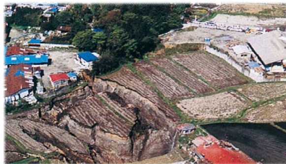
写真三 1991年4月29日発生の陥没
