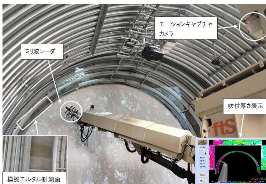
図3 模擬トンネル内での検証状況
